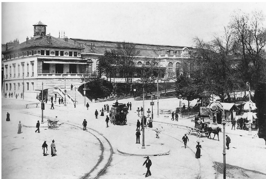
Photo 5 : Première gare de Cornavin, avec le remblai, vers 1900. Source : CIG ©.
