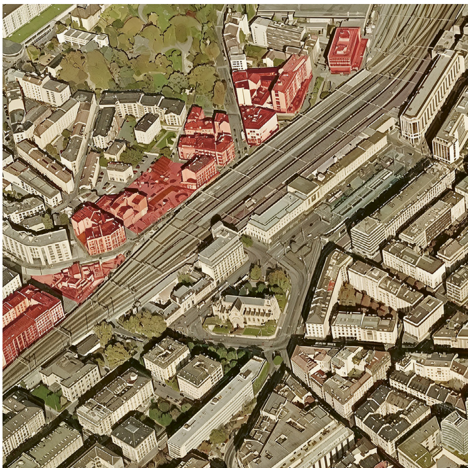
Photo 10 : Les immeubles condamnés par une extension en surface.
