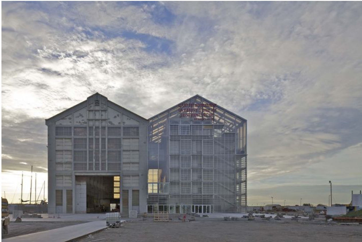
Frac Nord-Pas-de-Calais, Lacaton & Vassal, Dunkerque - © Philippe RUAULT
