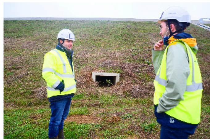
Visite du chantier COS de Vinci Autoroutes avec Arnaud Guillemin.
